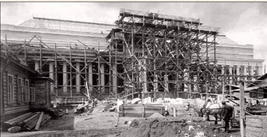
Строительство музея. Установка колонн центрального портика. 1905
