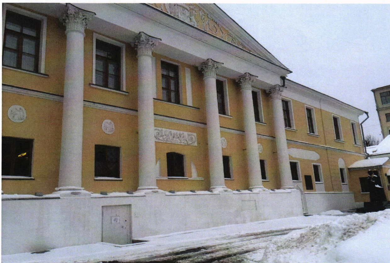
Фото № 2. Фрагмент главного фасада.
