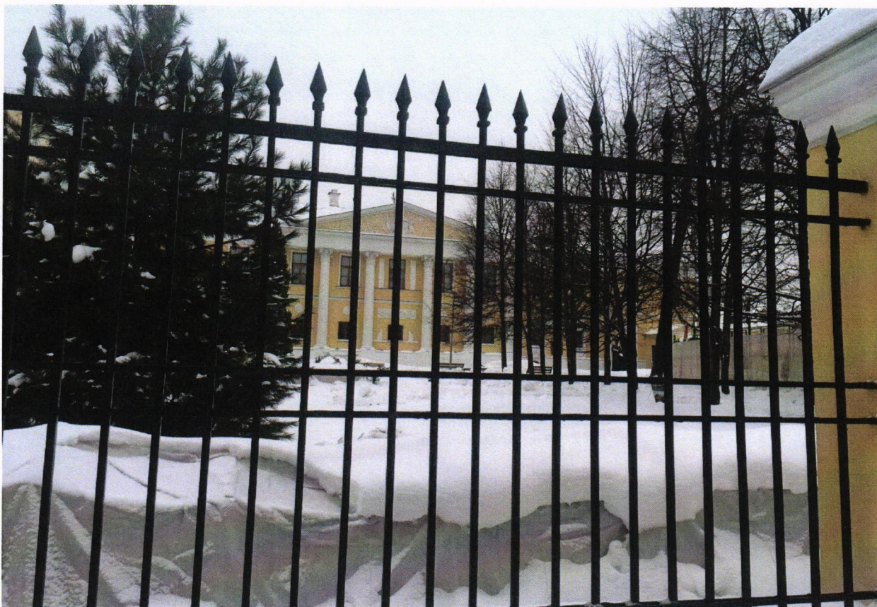
Фото № 1. Главный фасад.
