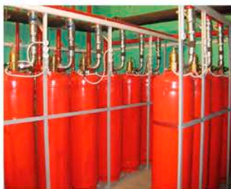
Установка пожаротушения с применением ФК-5-1-12 (Новек) в Государственном Центральном Музее Музыкальной Культуры им. Глинки М.И.
